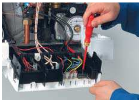
3. Подключение электрических присоединений
