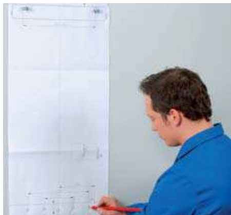
1. Предварительная разметка с помощью монтажного шаблона
