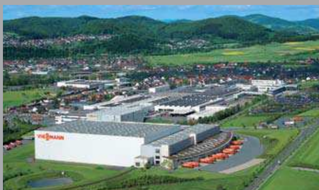
Завод Viessmann в г. Аллендорф / Германия
